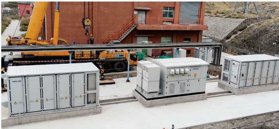
新疆风热储项目现场
